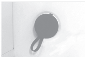
Fig. 5: Tappo di plastica per scarico condensa (il tappo chiude la vasca dall'interno)
