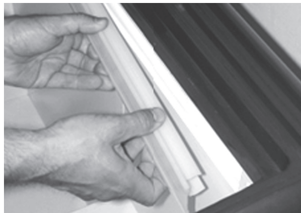
Abb. 6: Leuchtenabdeckung entfernen
