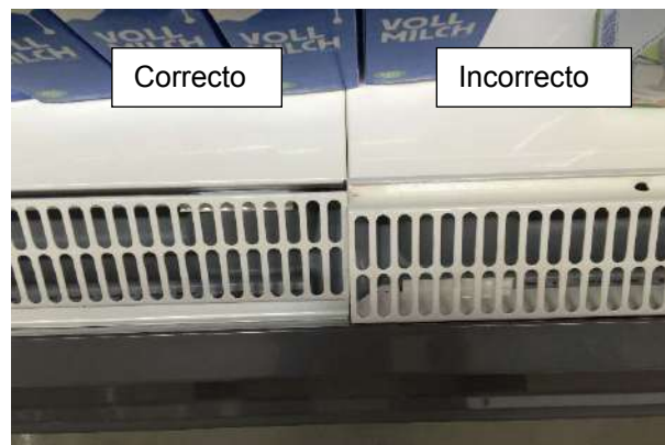
Fig. 1: posición de la rejilla de aspiración de aire (representación simbólica)
