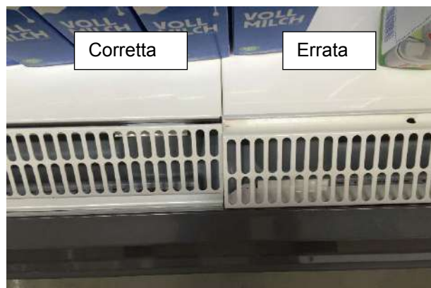
Fig. 1: posizione della griglia di aspirazione dell'aria (illustrazione a titolo d'esempio)
