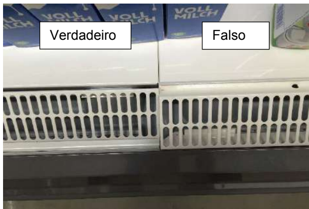
Fig. 1: Posição da grelha de entrada de ar (visor de símbolos)
