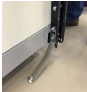
Abb.7.2: Gerätespezifische Kippsicherung
