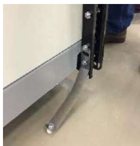
Fig.7.2: sicura antiribaltamento specifica dell'attrezzatura
