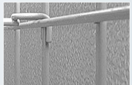
3.) Eisfreie Innenwand nach dem Enteisungsprozess
