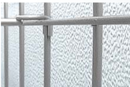
1.) Innenwand vor Beginn des Enteisungsprozesses
