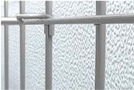
1.) Innenwand vor Beginn des Enteisungsprozesses
